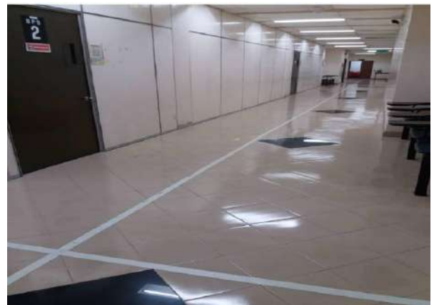
Lantai yang bersih, selamat dan tidak rosak
